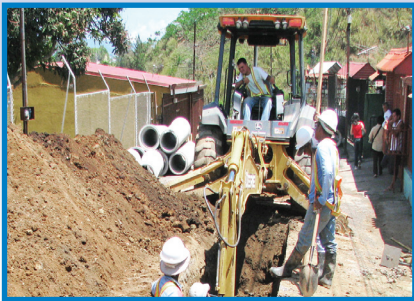
Obras realizadas en San Miguel
