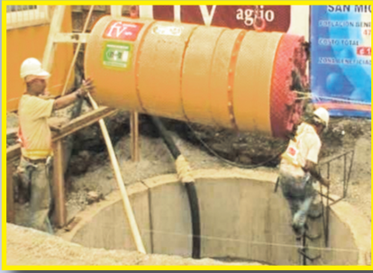
Tecnología pipe jacking
